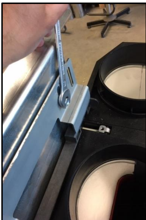
Figuur 9: Losdraaien HRU ECO 300 beugel
