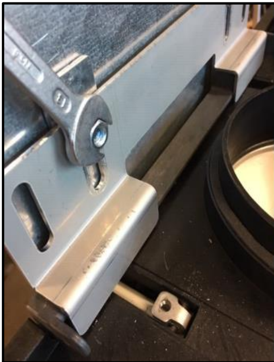
Figuur 10: Vastdraaien HRU ECO 300 beugel
